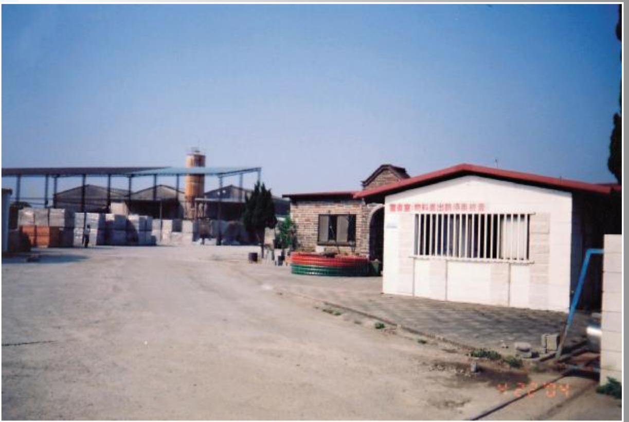
◆佰歲空心磚工廠，自動化切磚及運搬設備，有效減少人力，降低成本。
